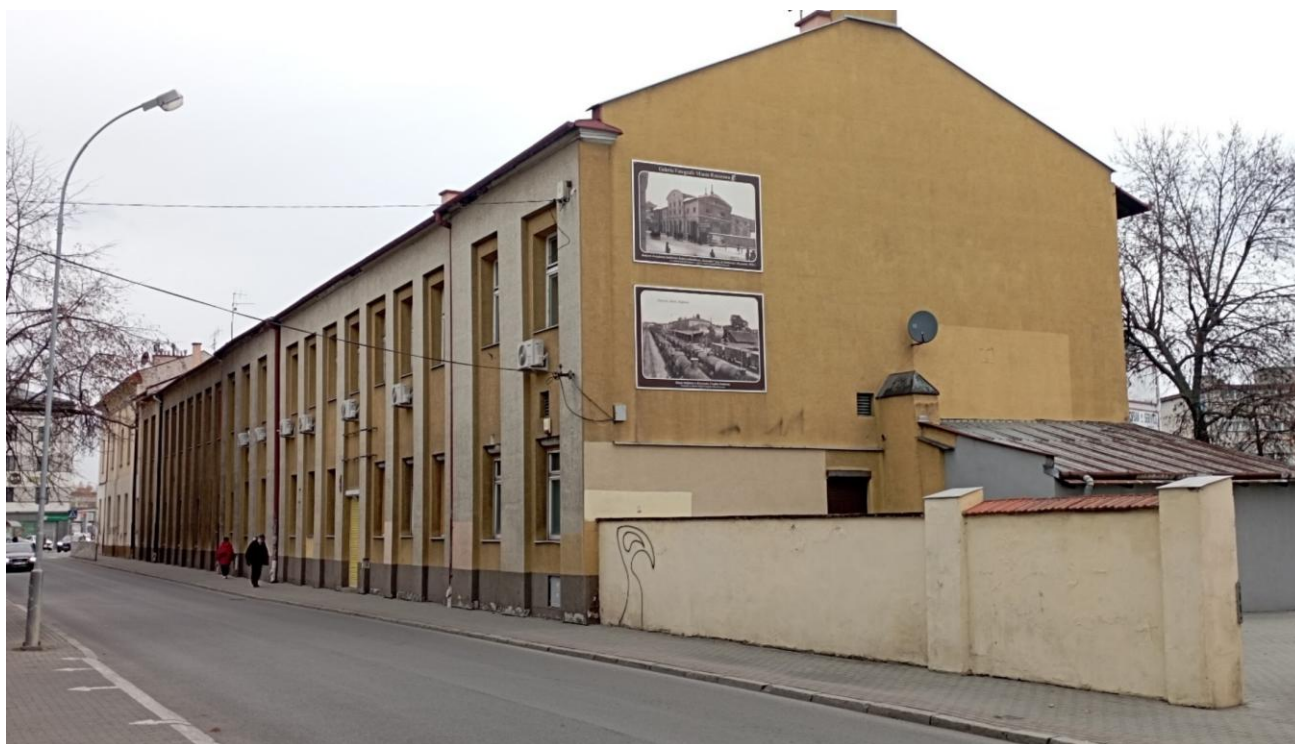
Fot. 1. – II Koszary Obrony Krajowej wraz z ogrodzeniem przy ul. Bardowskiego 2, widok od ul. Aleksandra Fredry (fot. Biuro ZIR).
