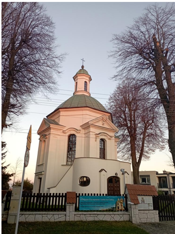
Fot. 9. – Kaplica Św. Huberta przy ul. św. Huberta 55 (fot. Biuro ZIR)
